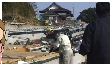
損害調査の様子
