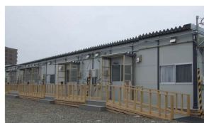
【出典】国土交通省HP「東日本大震災における応急仮設住宅の建設事例」
